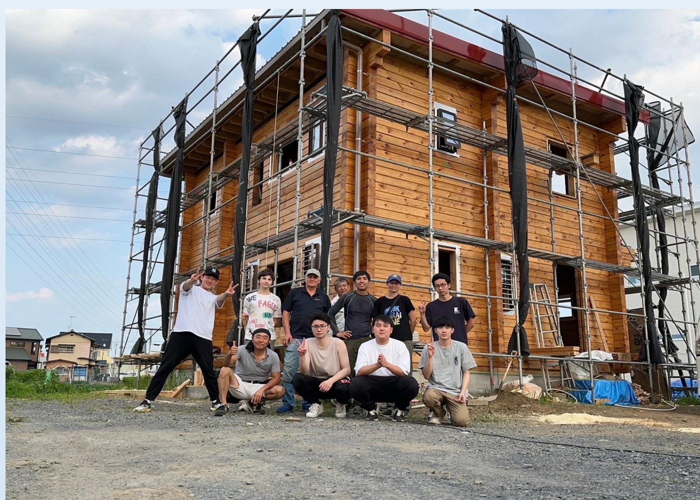
I ログハウス建設
